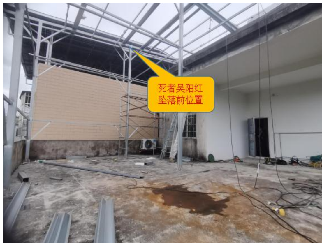
图二 事发光伏电站建设作业平台
