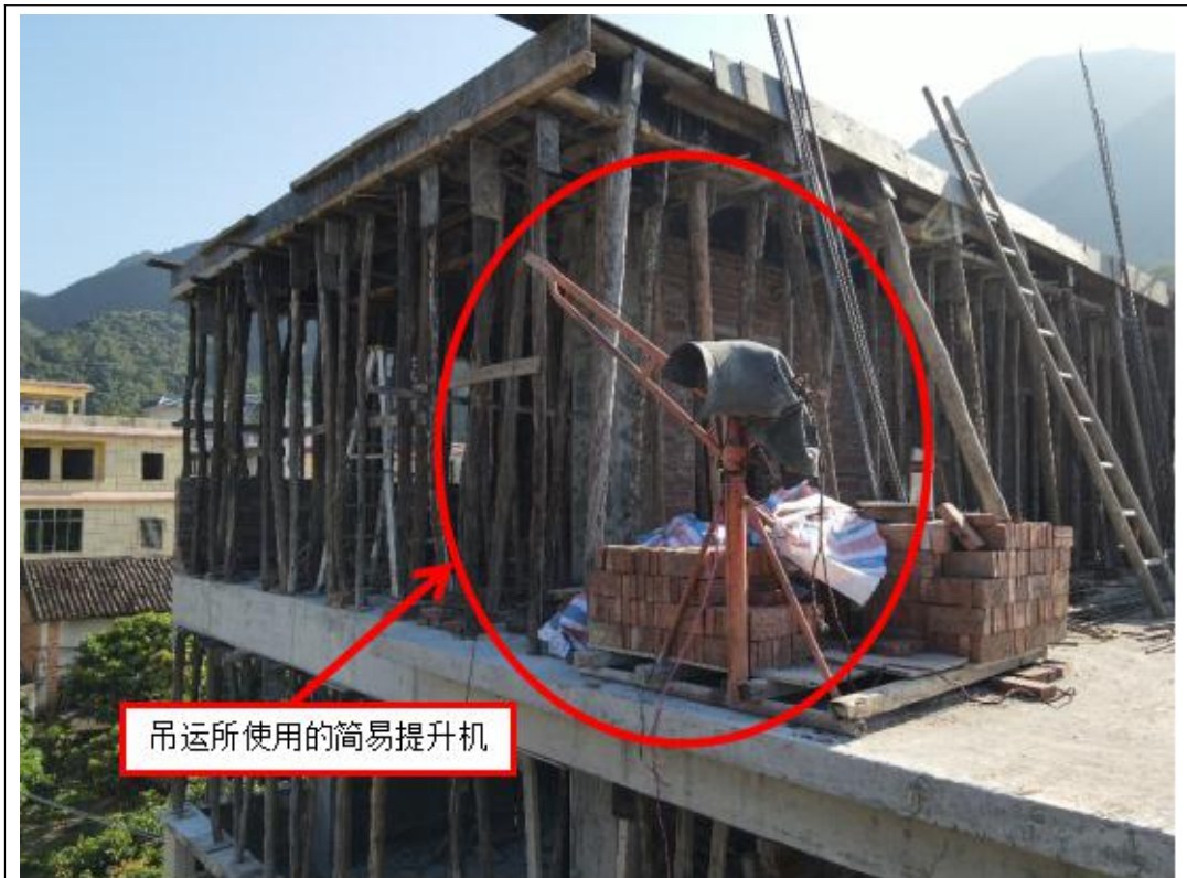
图 4 事发使用的简易提升机
