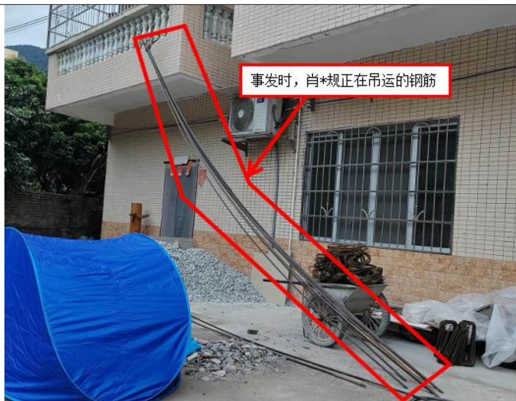
图 5 事发时吊运的钢筋
