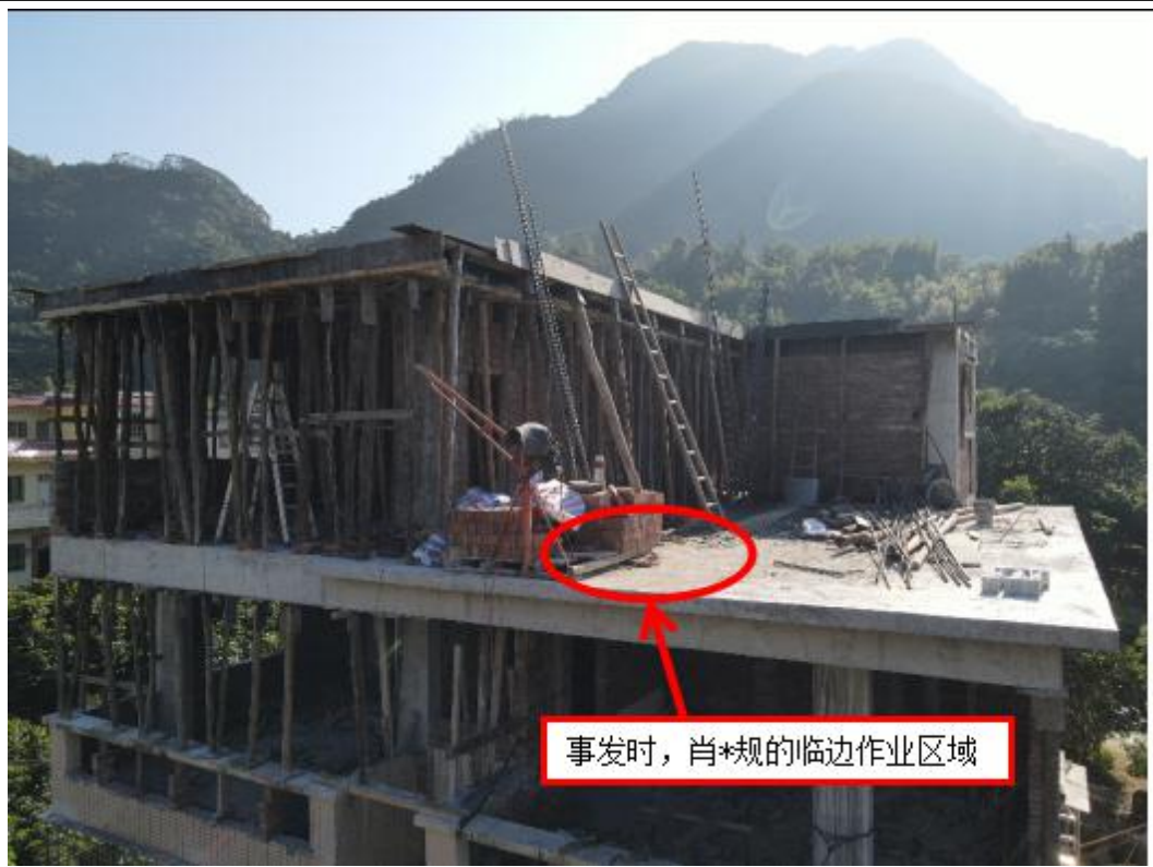
图 3 施工作业现场环境
