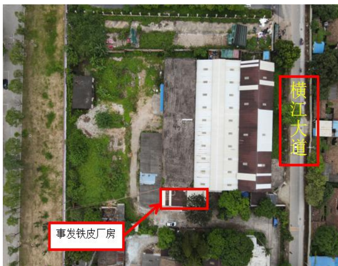
图一 事发铁皮顶厂房俯视图
