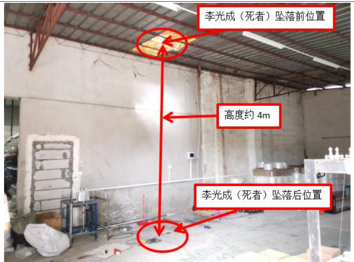
图二 事发铁皮顶厂房室内坠落位置情况
