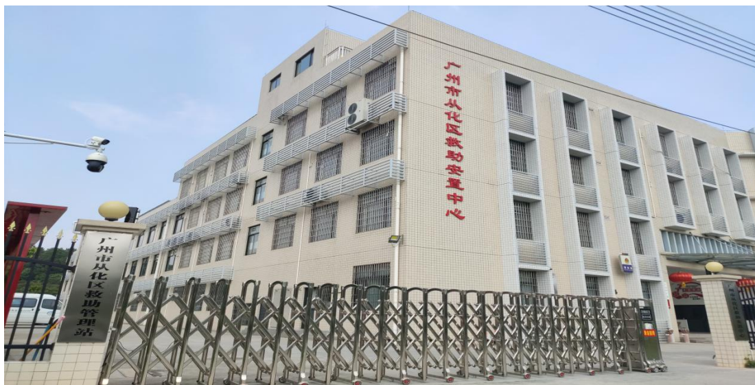
上图为安置中心建设外观
