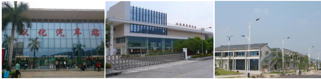
图 2-3 从化汽车站、温泉客运站、鳌头镇中心客运站
